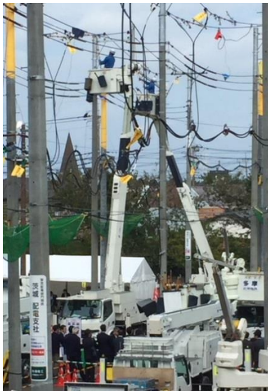
架空配電部門 (柱上変圧器取替作業)
